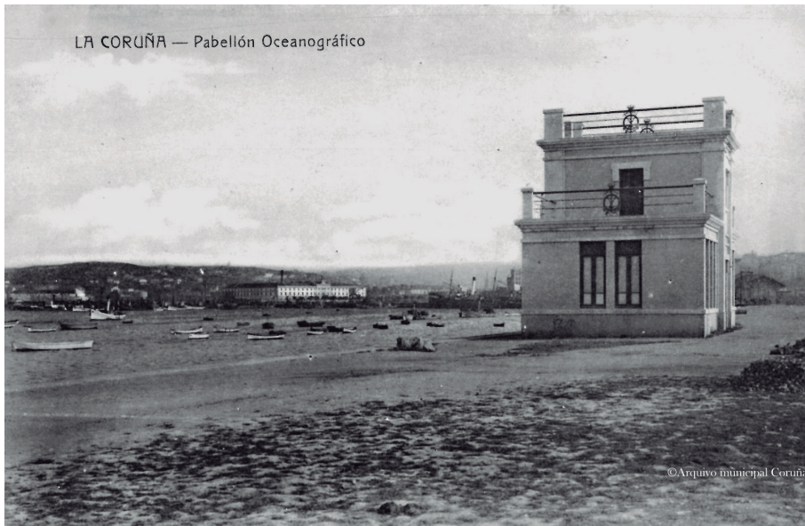
Figura 10: Pabellón Oceanográfico, sede del Real Subcomité de la Coruña de la Sociedad de Oceanografía del Golfo de Gascuña (Fuente: Arquivo Municipal de A Coruña).
