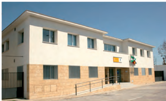
Imagen 1. El Centro Oceanográfico de Cádiz del IEO después de la remodelación integral a la que se sometió el edificio y que volvió a ser ocupado en julio de 2008. Sitio en el muelle de Levante del puerto pesquero de la capital gaditana, albergó hasta 1985 las instalaciones del antiguo Instituto de Investigaciones Pesqueras de Cádiz del CSIC (hoy Instituto de Ciencias Marinas de Andalucía) [archivo del CO de Cádiz].
