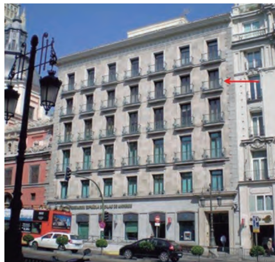
Imagen 1. Sede Central del IEO en la calle Alcalá (4º piso) hasta 1987.
