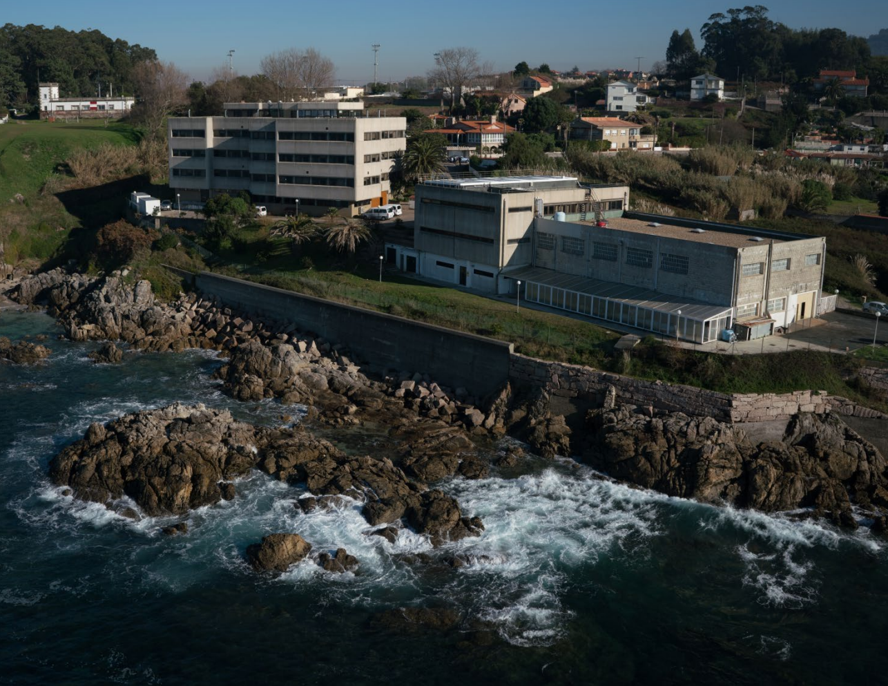
Instalaciones del Centro Oceanográfico de Vigo (COV) en Cabo Estai. A la izquierda, el edificio principal; a la derecha, la Planta de Cultivos.
